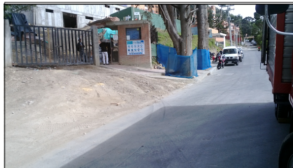
Figura 14. Espacio público afectado por inadecuado manejo de material de arrastre
