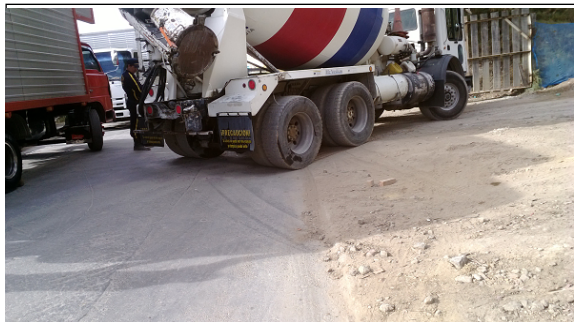
Figura 13. Arrastre de material proveniente de la obra por la acción de vehículos
