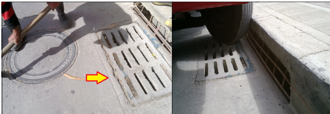
Figura 5. Sumidero desprotegido en la entrada de la obra
